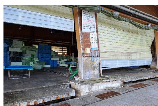
共同利用施設(輪島市輪島港)
