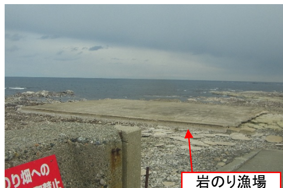
漁業用施設(北部珠洲地区)
