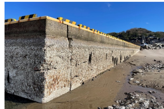
漁港施設(輪島市黒島漁港)
