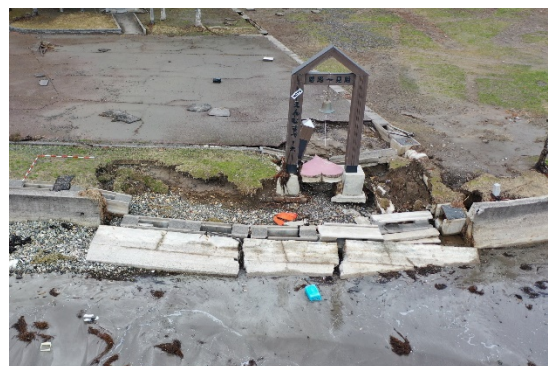
海岸保全施設(珠洲市鵜飼漁港海岸)
