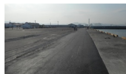
応急復旧の実施
