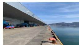
本復旧（原形復旧）の実施
