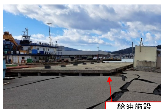
共同利用施設(輪島市輪島港)
