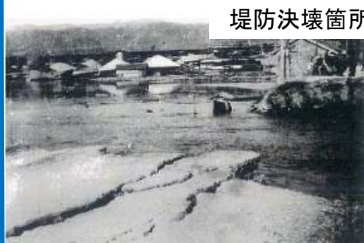
昭和南海地震での堤防決壊箇所(葛島橋付近)
