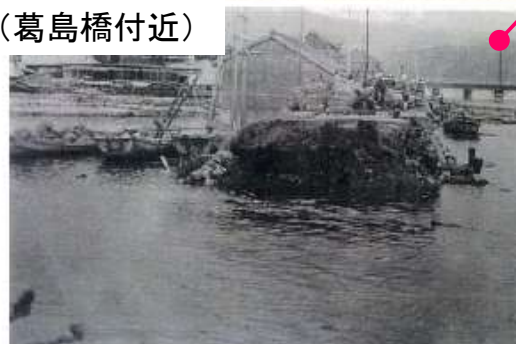
昭和南海地震での堤防決壊箇所(葛島橋付近)
