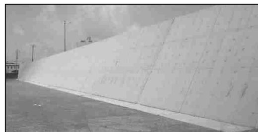
津波から背後地域を守る胸壁 (御前崎港海岸)
