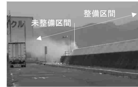
平成24年台風第16号に伴う高波の越波状況
