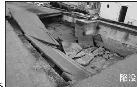
老朽化の進行による 海岸保全施設の損傷例
