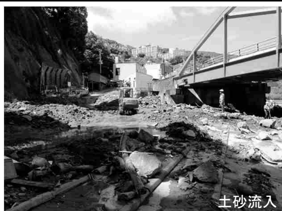
臨港道路及び泊地の被災(熱海港)
