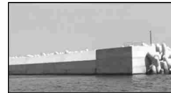
上部工の嵩上げ
