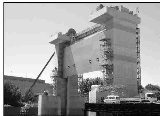
津波から市街地を防護する水門 (和歌山下津港海岸)
