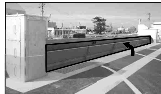
フラップゲート式の陸閘 (津松阪港海岸)
