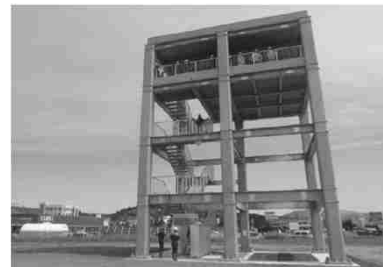
津波避難タワー(船川港)
