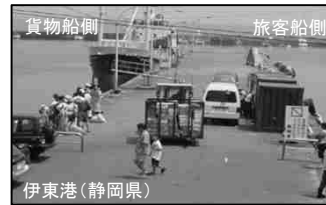
物流と人流が混在する狭隘な棧橋
