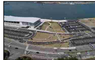
金沢港 (緑地・道路の整備)
