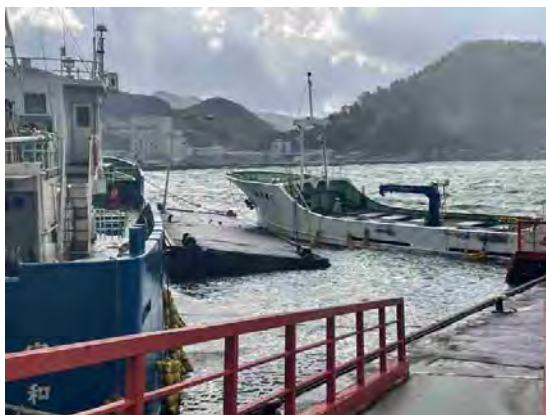
棧橋の被災[宇和島港(愛媛県)]
