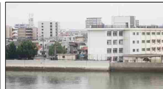
高潮等から市街地を防護する護岸 (広島港海岸)
