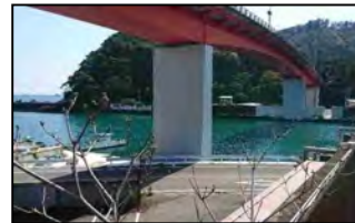
長島港 (橋梁の改良)
