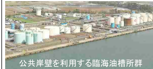
製油所で生産された石油製品の約6割は内航タンカーで臨海油槽所へ輸送
