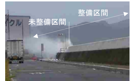
平成24年台風第16号に伴う高波の越波状況
