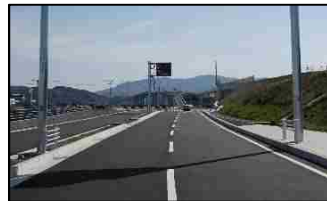
徳島小松島港 (臨港道路の整備)
