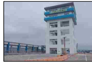
新島港 (津波避難施設の整備)
