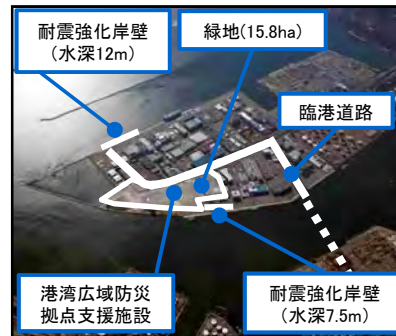
基幹的広域防災拠点(川崎港)
