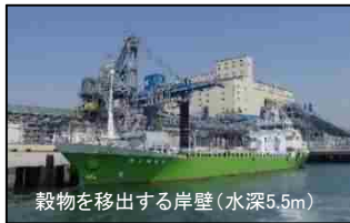
水島港 (岸壁の整備)
