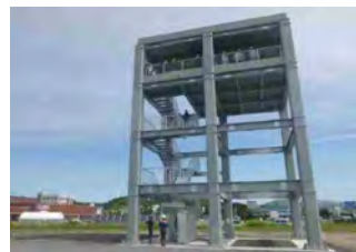
津波避難タワー(船川港)
