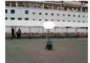
照明設備【仙台塩釜港】
