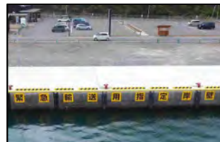
くれ久礼港 (岸壁の改良)
