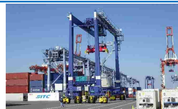
遠隔操作RTG
