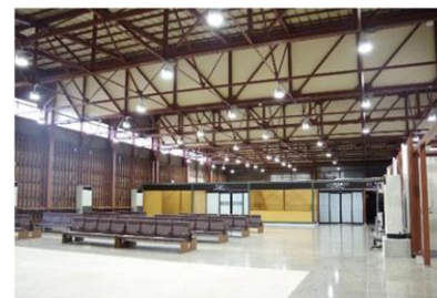
＜旅客上屋等の改修：舞鶴港＞ （待合施設、空調設備、便所設備）
