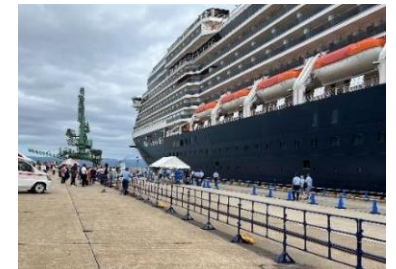
＜貨客分離フェンス：伏木富山港＞ （旅客動線の効率化）
