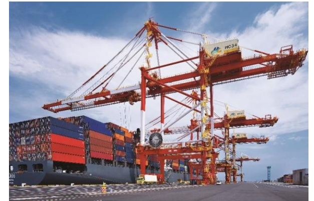
ガントリークレーン
