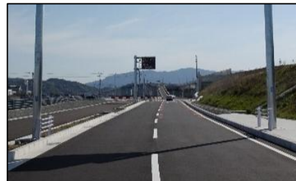
徳島小松島港 (臨港道路の整備)
