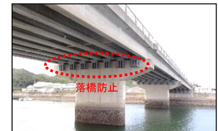
新居浜港 (橋梁の改良)
