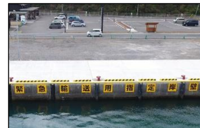
くれ 久礼港 (岸壁の改良)
