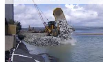
②仮設道路整備状況(3/19~)
