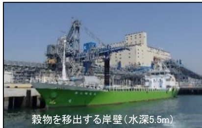
水島港 (岸壁の整備)
