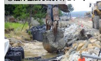
③護岸撤去状況(6/24~)
