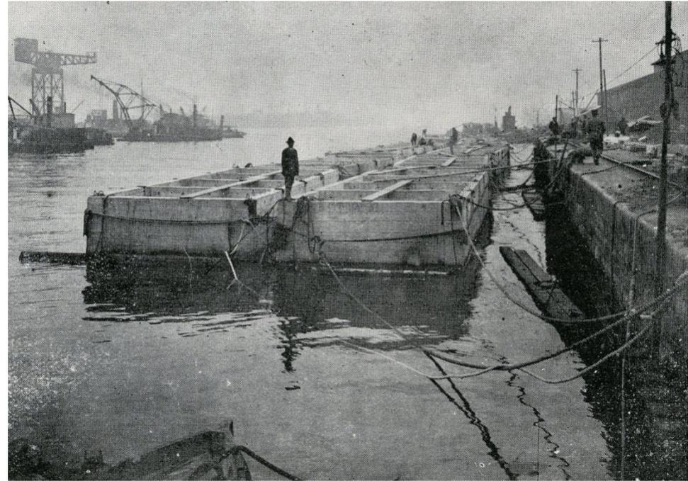
新港ふ頭の岸壁の復旧に使われた鉄筋コンクリート製のケーソン 『横浜港震害復旧工事報告 附震災救護報告』より
