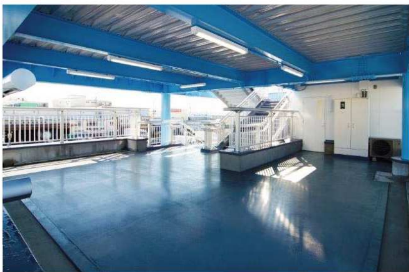
避難階 2階全景
