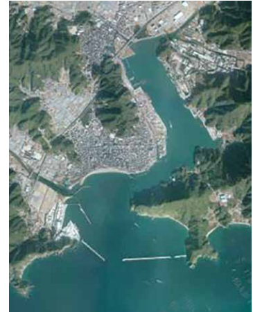
須崎港津波防波堤
