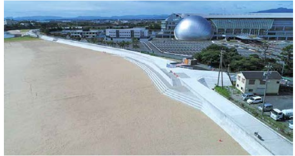
阿漕浦御殿場工区現場写真
