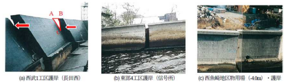
1995年兵庫県南部地震による護岸の被災例(神戸市, 1998)
