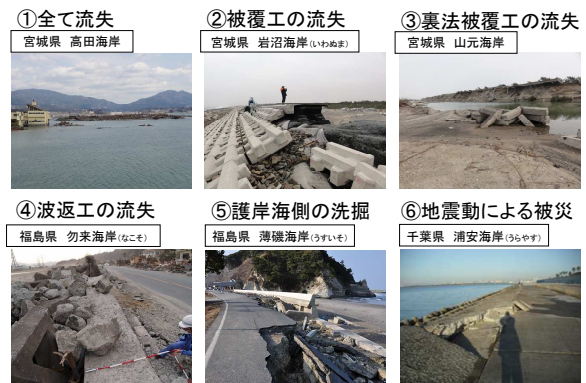
図8 堤防・護岸の被災例
