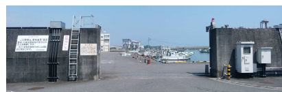
(1) 開口部 右側の堤体の向う側に (2) の扉体がある。
