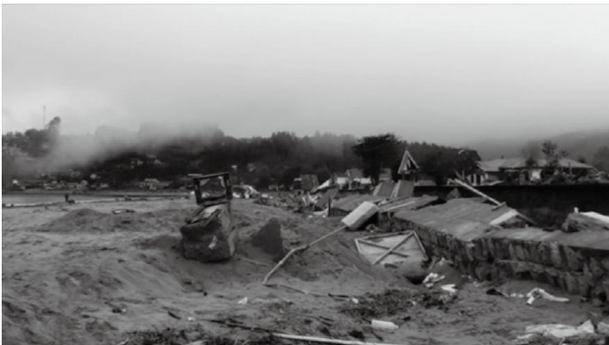
写真3 津波により倒壊した海岸護岸 (Dichato, 2010年4月1日撮影)
