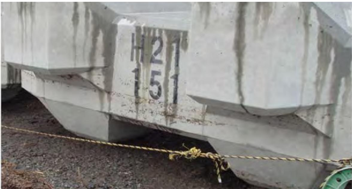
浸水痕跡（宮古港：ブロック側壁の付着物）
