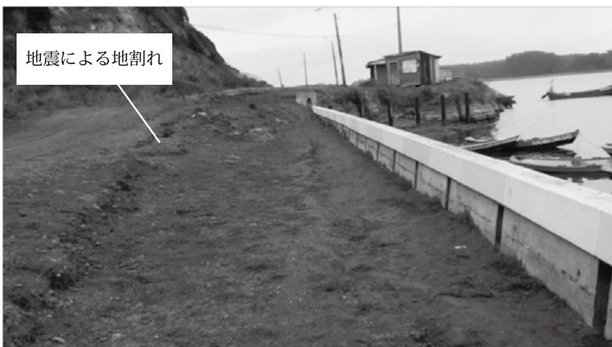
写真4 地震により前傾した護岸 (P. Saavedra, 2010年4月27日撮影)
