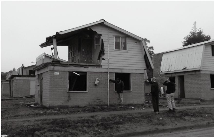
写真1 津波により破壊された家屋の例 (Dichato, 2010年4月1日撮影)
