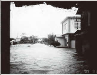
浸水状況(平成11年台風18号)
