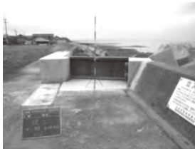
鋼製門扉の設置
