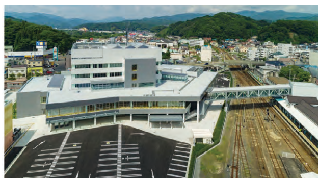
宮古市中心市街地拠点施設
