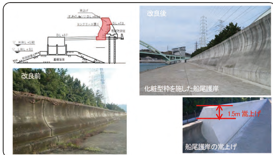
図-4 船尾護岸の整備状況
