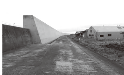
防潮堤嵩上改良中
