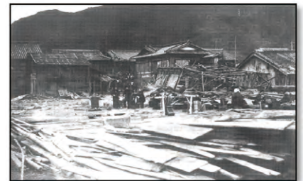
写真-1 昭和南海地震の被害状況 (写真はいずれも海南市) 出典：南海道地震から50年（平成8年：和歌山県）
