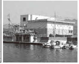
整備状況(排水機場)
