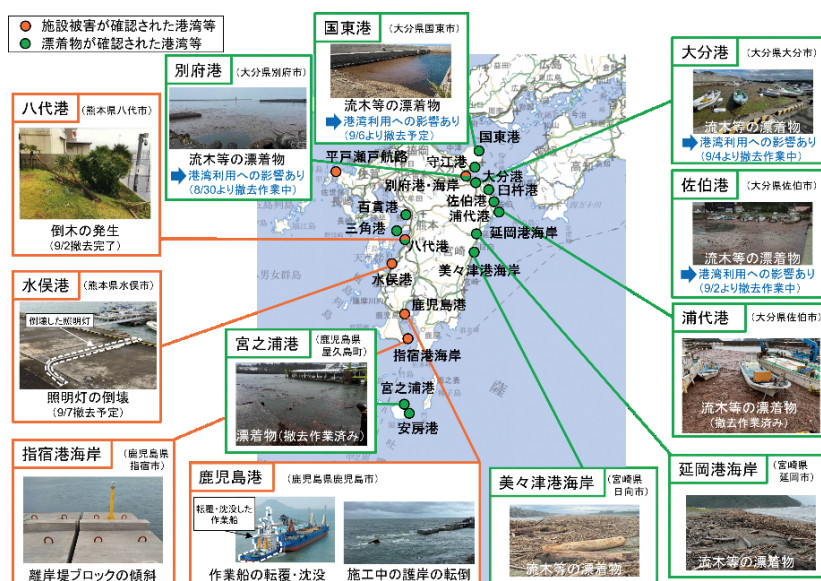
図1 台風10号による港湾の被害
