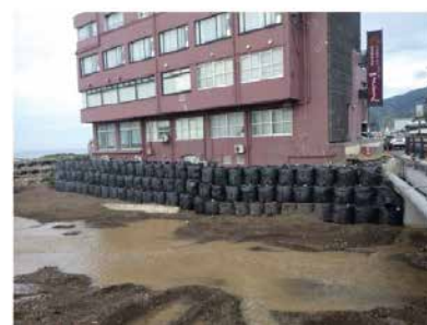
海岸護岸の応急復旧（輪島港）
