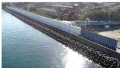
写真-4 施工状況
