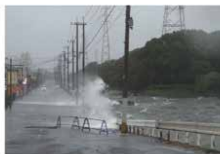
写真-2 越波状況
