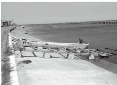
海岸護岸の整備状況
