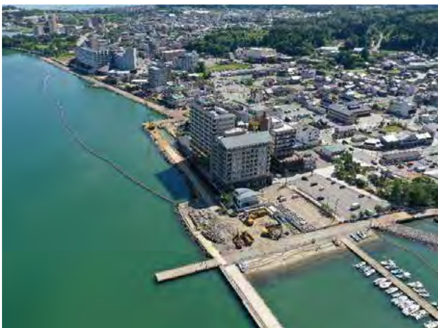
《和倉温泉の護岸復旧工事》
