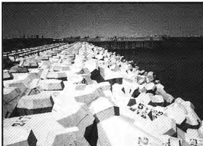
消波・根固ブロック クリンガー
