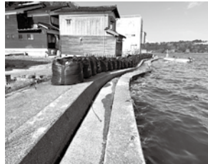
海岸護岸応急復旧状況
