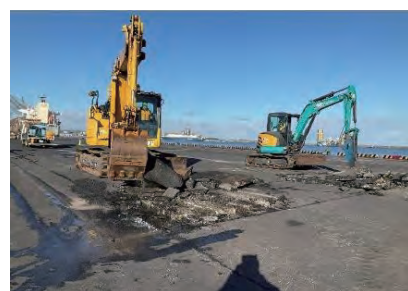
(b) 応急復旧工事状況 (八戸港)
