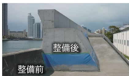
図-1 海岸の地震・津波対策事例 (和歌山下津港海岸)
