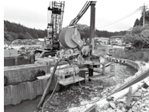
矢板圧入工法
