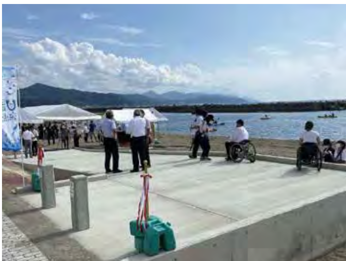
写真1 完成したスロープ（竣工式典）
