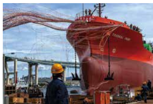
古川佐代美 進水作業完了
