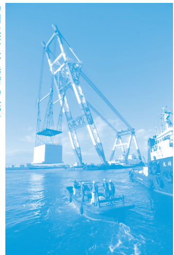
「護岸工事」中村 光雄
