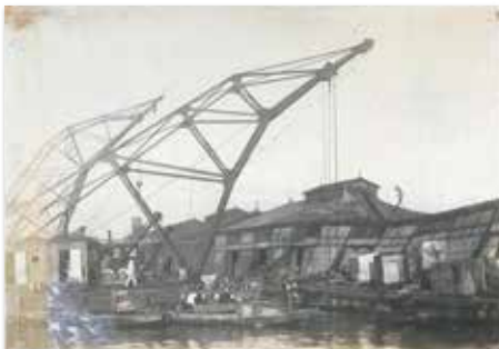
新港ふ頭の岸壁復旧工事 1923~1924(大正12~13)年 横浜港の復旧工事は約2年という驚異的な速度で完成した
