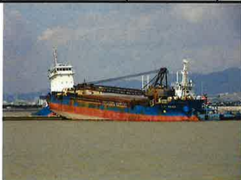
⑧船舶の乗上げ(防波堤損壊)
