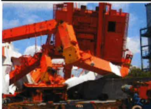
⑨クレーン倒壊 (防潮堤損壊)
