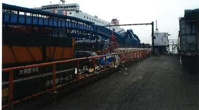
⑥ボーディングブリッジ倒壊状況 (全景)
