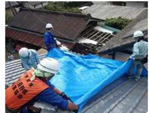
ブルーシートの設置状況(芝山町)
