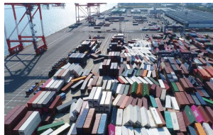
コンテナの散乱状況 (神戸港)
