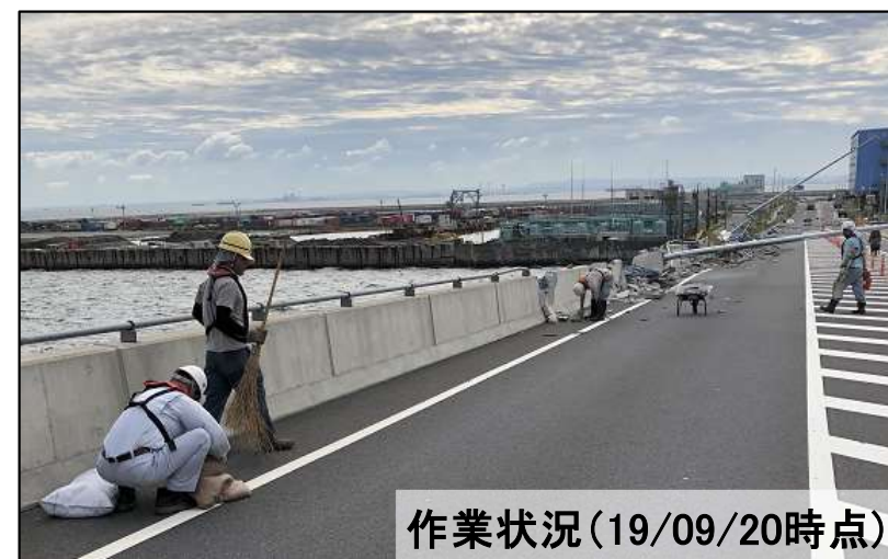
作業状況(19/09/20時点)
