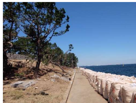
護岸応急復旧状況 (9月19日撮影)
