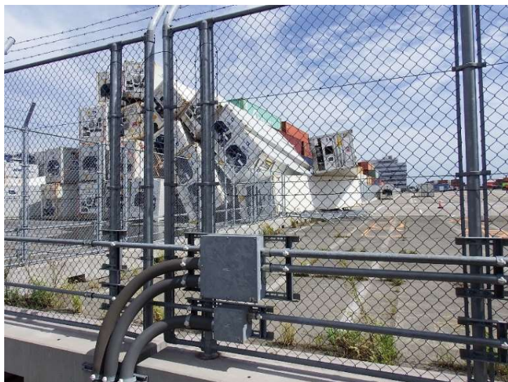
D4コンテナ倒壊
