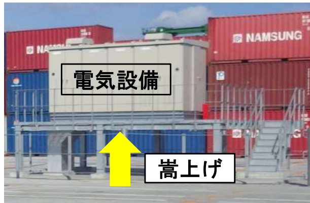
電気設備の嵩上げ事例
