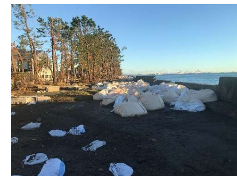
土のう(第1ライン)の一部崩壊 (10月13日撮影)
