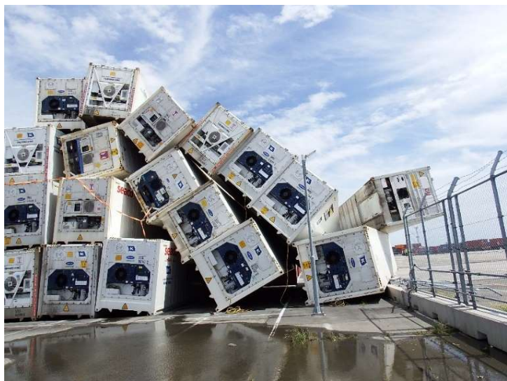
D1 空コンテナ、SOLASフェンス倒壊
