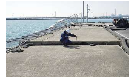
岸壁の点検状況
