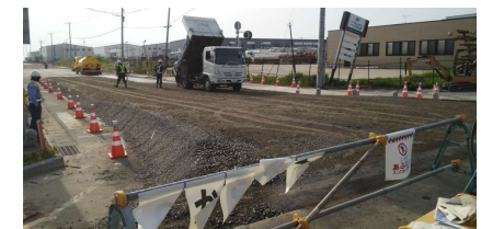
臨港道路の応急復旧工事
