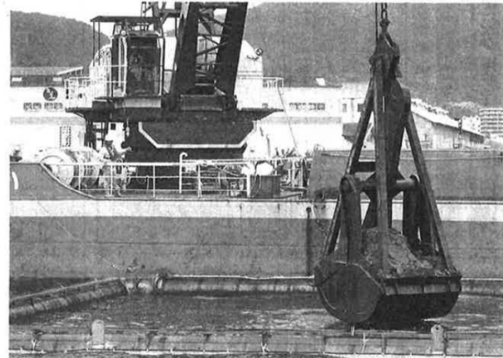
西日本豪雨で流入した海底の土砂を浚渫する作業船—呉港
