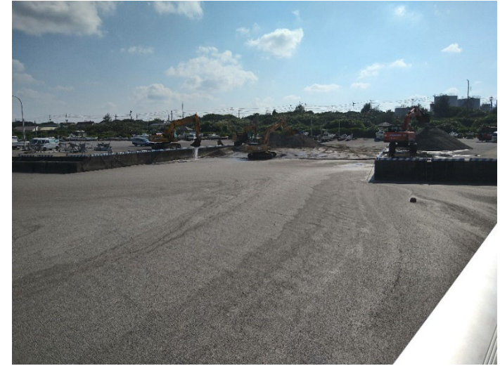
与論港軽石除去作業（撮影日11月1日）
