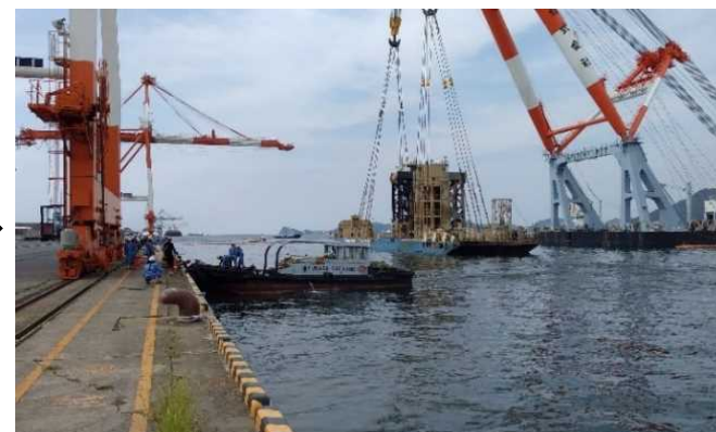
船体引き揚げの状況(8月29日)
