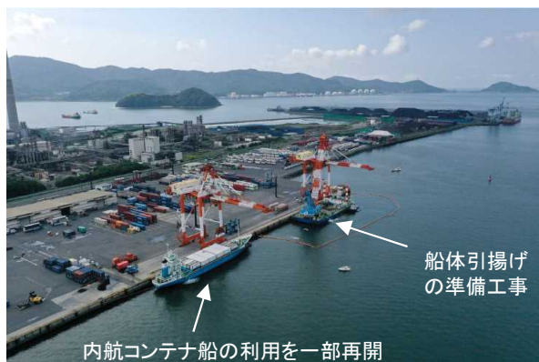
内航コンテナ航路の一部利用再開 (8月9日から。写真は8月22日)
