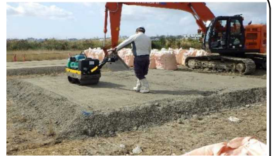
試験体の敷均し・転圧の様子
