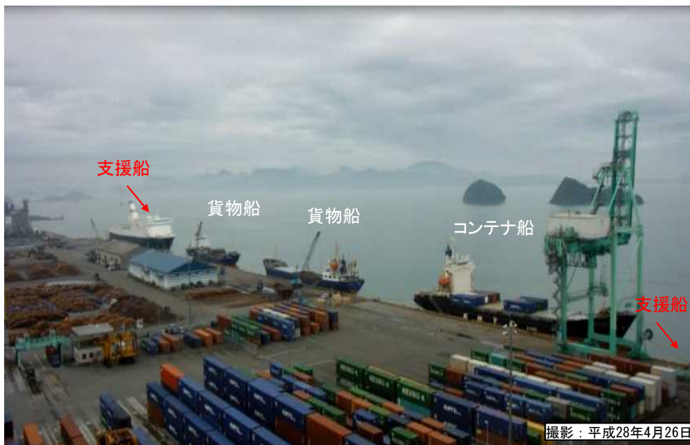
熊本地震発災後の八代港
