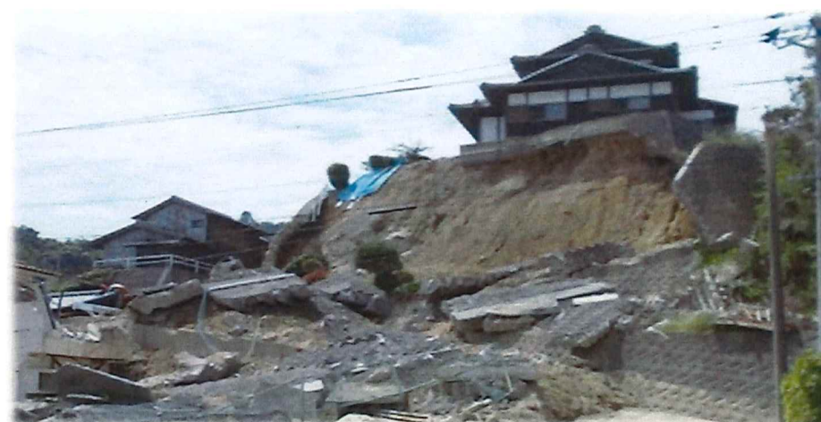
【蒲刈町田戸】崖崩れ
