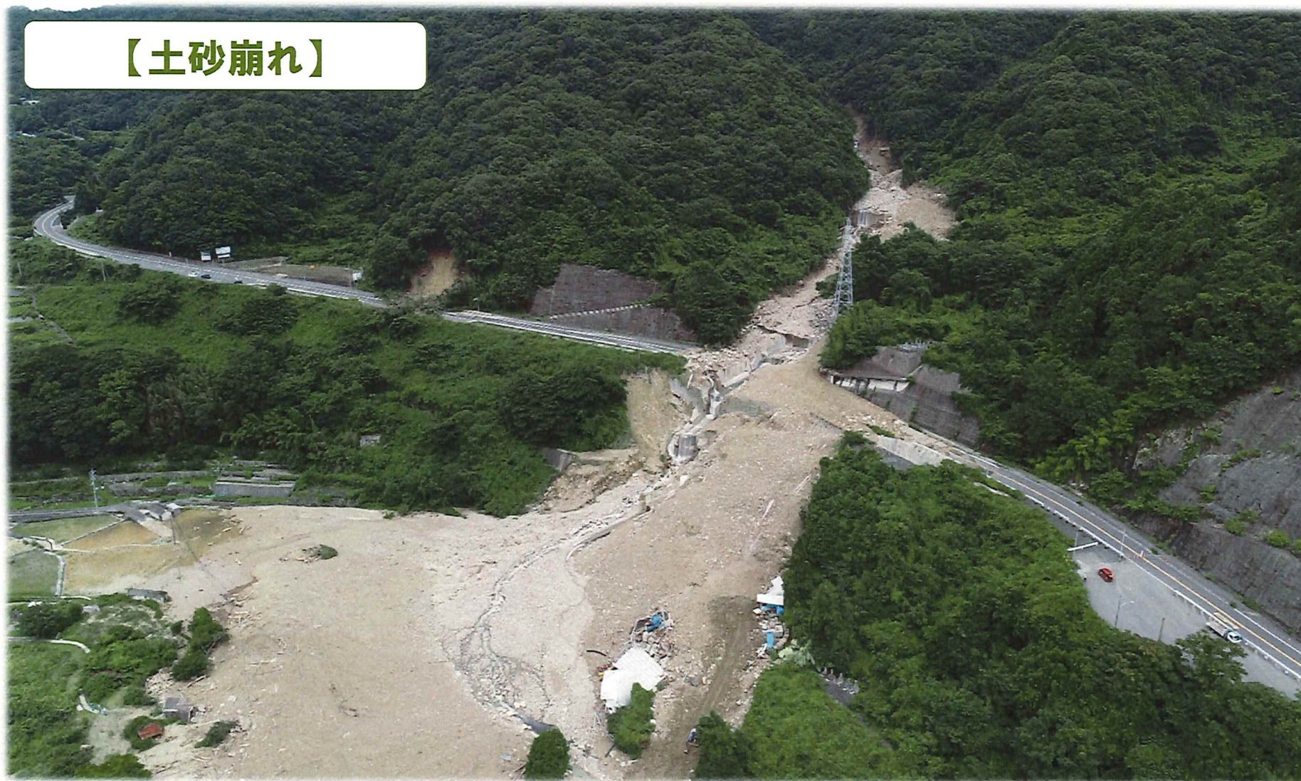
土砂崩れにより閉塞した国道375号（平成30年7月9日撮影）
