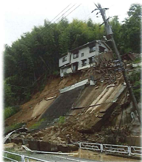
【広長浜 1 丁目】崖崩れ
