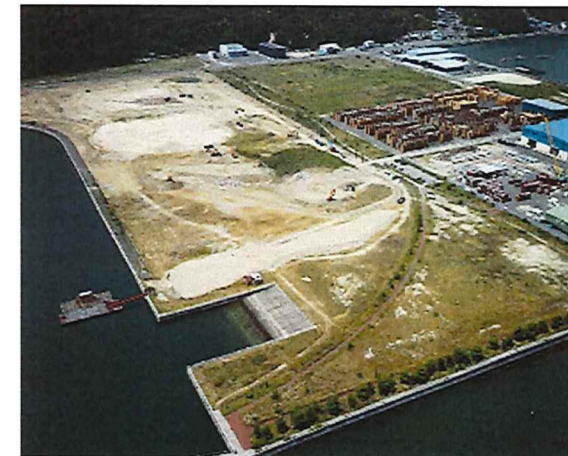
阿賀マリノポリス地区 海上積み出し拠点
