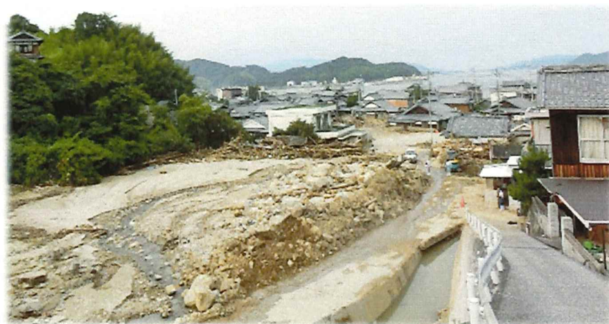
【音戸先奥 3 丁目】土石流
