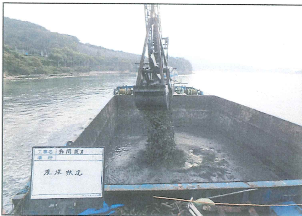
ガット船での浚渫状況
