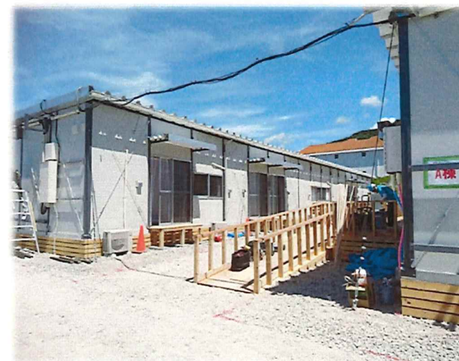
天応地区の建設型応急仮設住宅 ⑤
